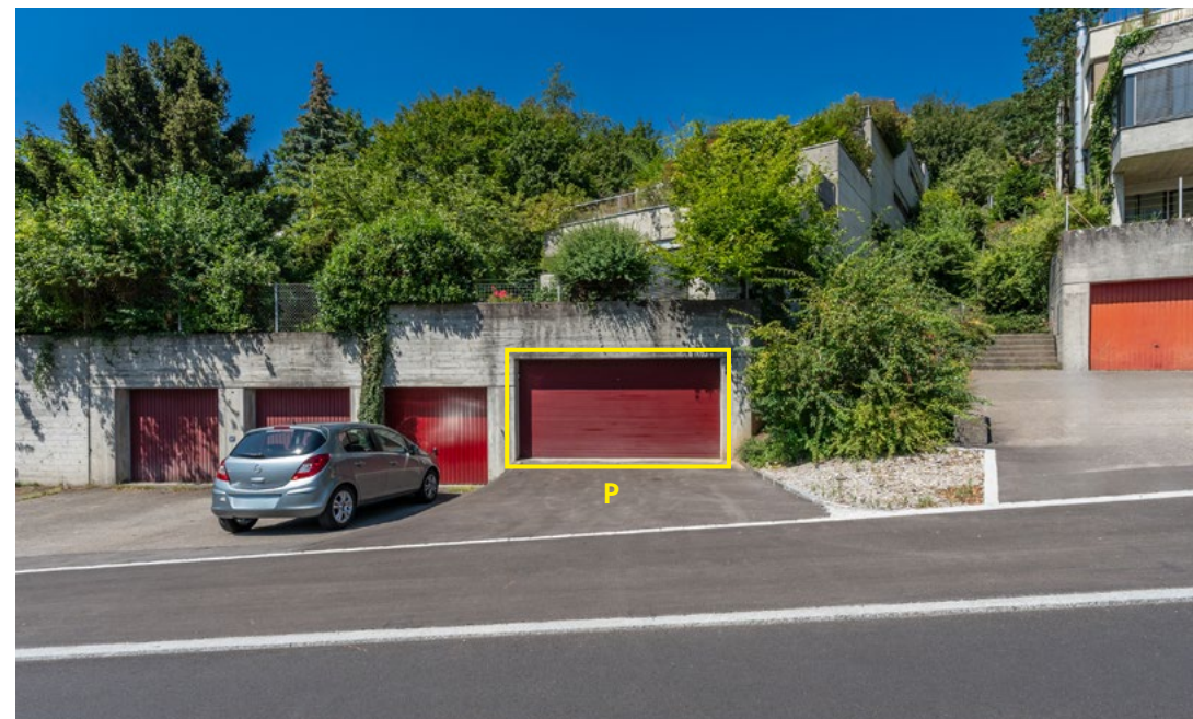
Doppelgarage mit Vorplatz
