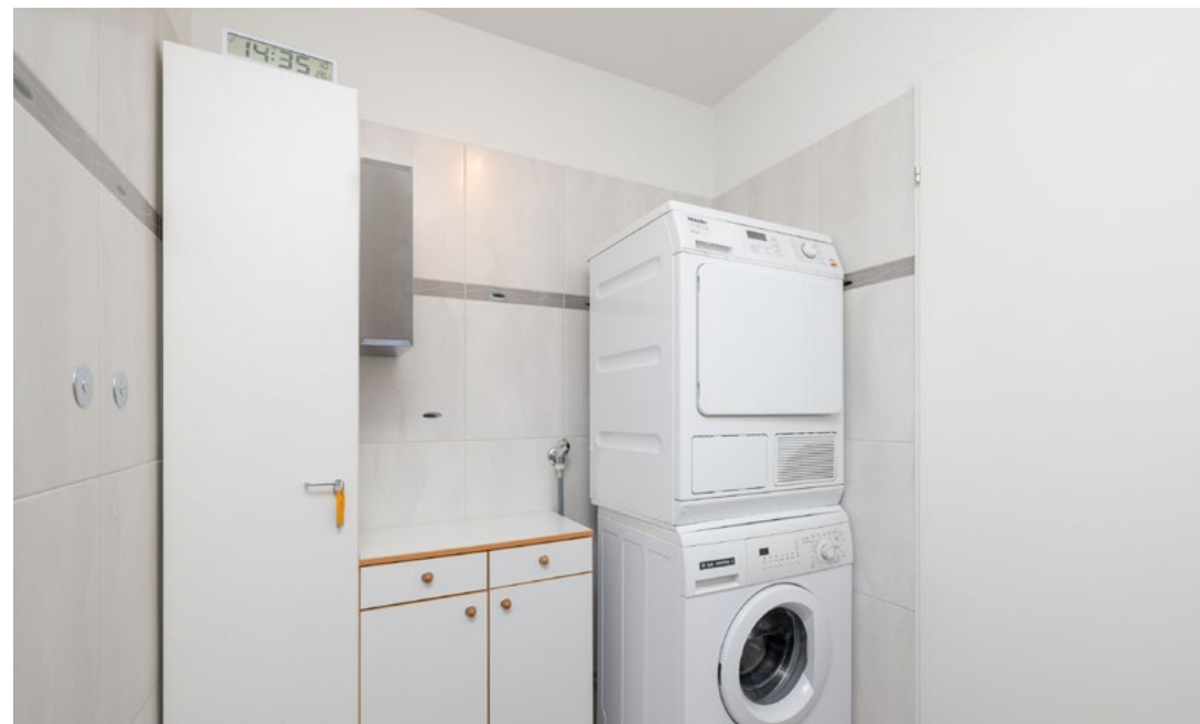
Gäste-WC mit Waschturm (Anschlüsse für Dusche vorhanden)
